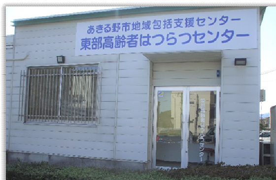
東部高齢者はつらつセンター (平成 31 年 4 月新設)
