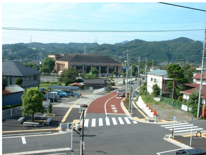
バリアフリー化された道路
