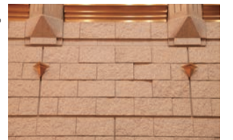
花崗岩が使用されたホール内壁面
