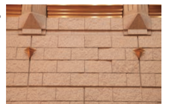
花崗岩が使用されたホール内壁面
