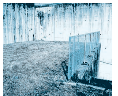
敷地内階段あがったところで撮影
