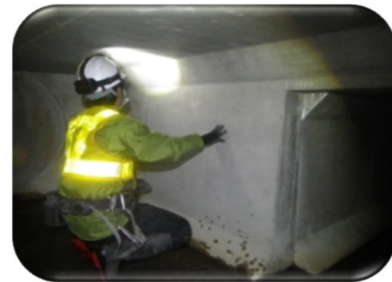
打音点検状況
