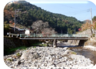
養沢川に架かる平和橋 昭和49年竣工
