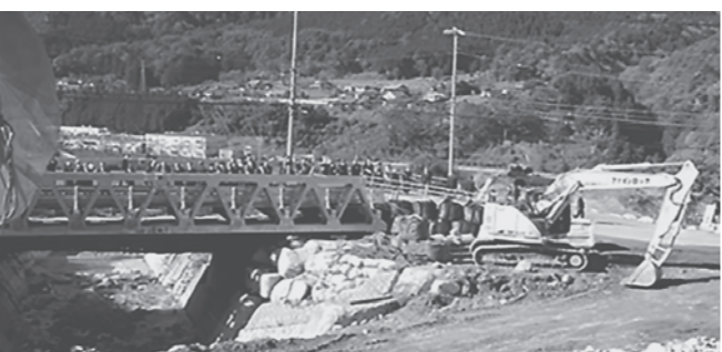
梨子沢の仮設橋上より被災地視察
