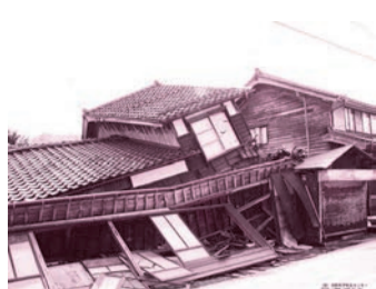
写真提供 (一財) 消防防災科学センター 「災害写真データベース」
