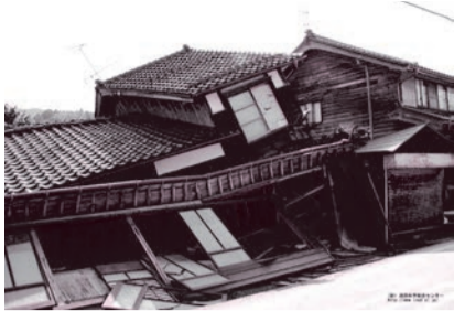
写真提供:(一財)消防防災科学センター「災害写真データベース」
