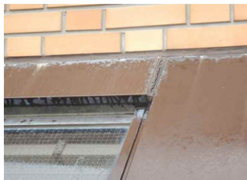
建具廻りシーリング破断（D）
