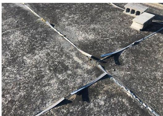
押さえコンクリート目地飛出し (D)
