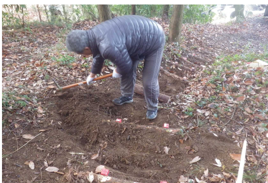
写真4 尾根道の補修（整備） 階段作り
