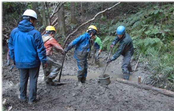
池チーム 池を掘り水路作り
