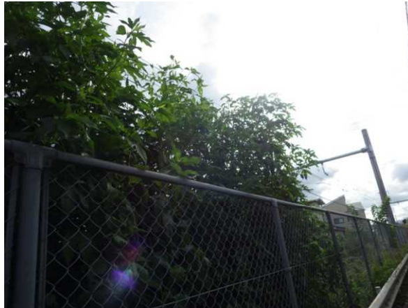
図 25 住宅前における繁茂による日照の阻害
