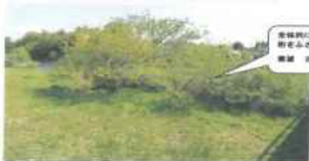
写真 2 引田橋より右岸上流 京浜と増積砂利で高く保った河床
