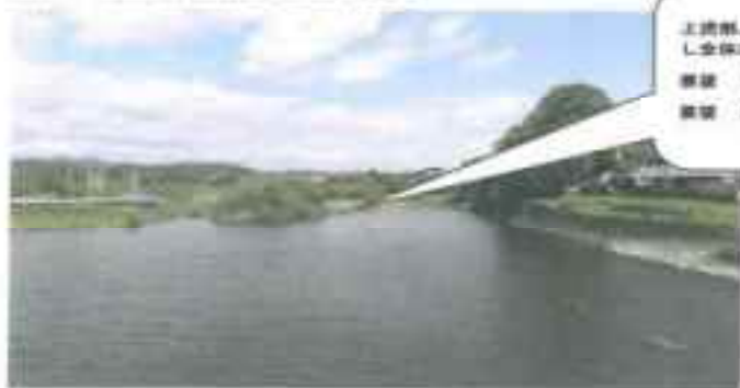
写真 1 引田橋より上流を望む(橋脚・砂りば)
