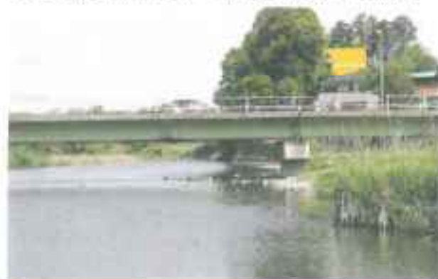
写真 3 橋より引田橋上流を望む 増積した砂利により河下が深くなった
