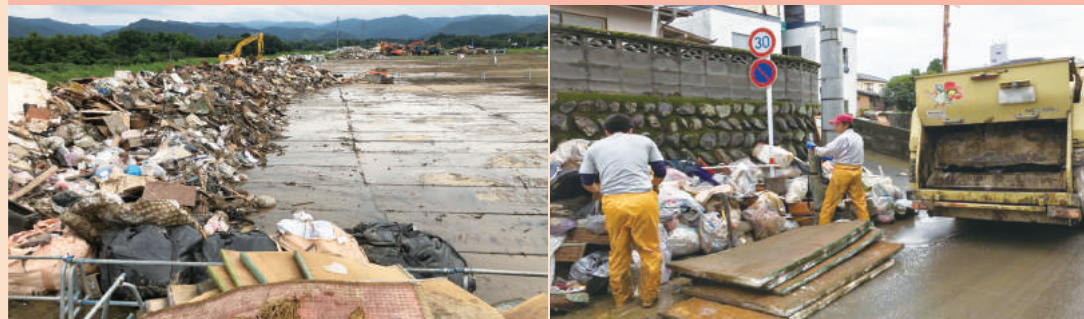
いずれも、2020年7月豪雨 熊本県人吉市の災害廃棄物処理の様子
