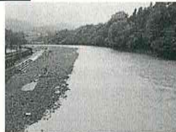
工事前(台風直後)
