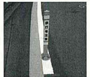
安全ポールの設置
