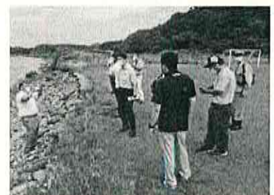
サッカー場護岸(切欠)
