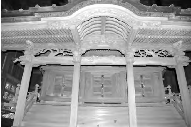
写真4 雨武主神社本殿 正面
