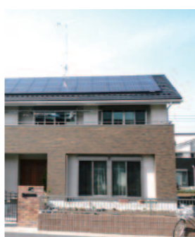
屋根に太陽光発電パネル
