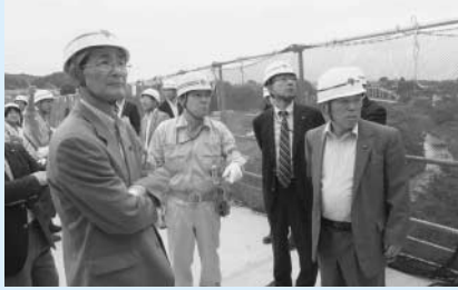
建設中の高瀬橋（仮称）で進捗状況を確認 （手前左：町田委員長、手前右：浦野副委員長）
