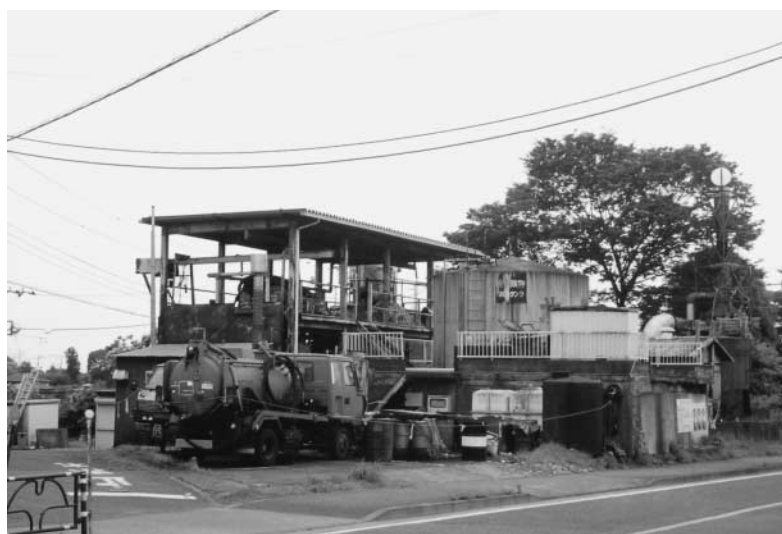
旧第一油化跡地
