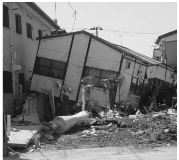
津波で倒壊した家屋（宮城県石巻市）
