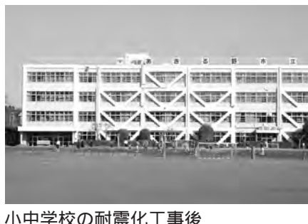
小中学校の耐震化工事後
