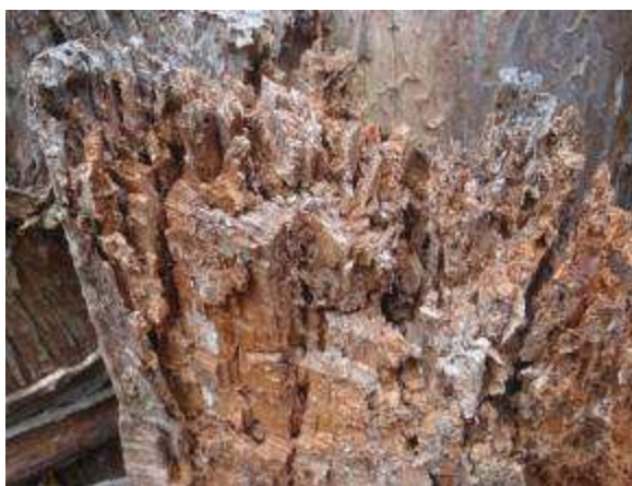
褐色腐朽：ブロック状にバラバラに腐朽する
