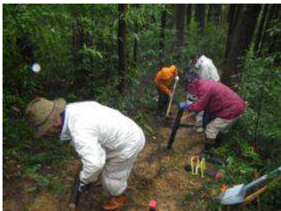
階段設置作業
