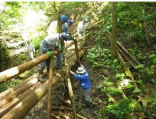
沢を渡る橋の設置作業
