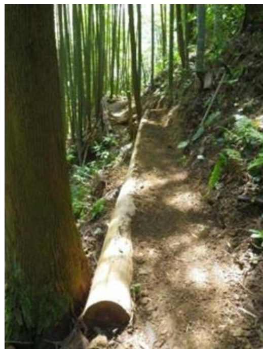
探索路の整備後
