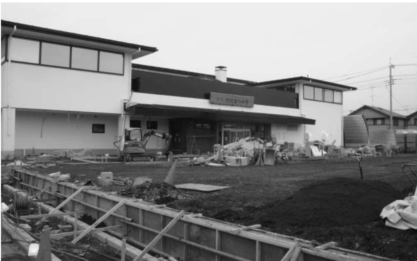
建設が進む秋川三丁目の温浴施設
