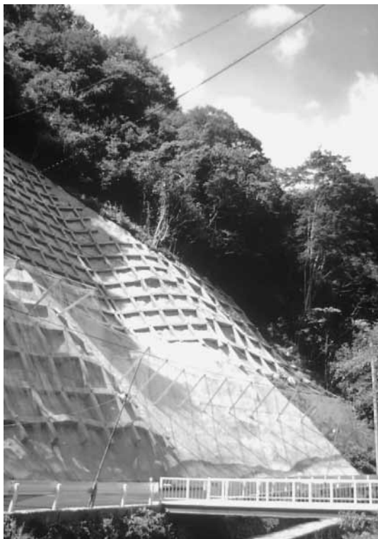
整備された養沢の崩落現場
