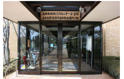
④玄関(近景)
