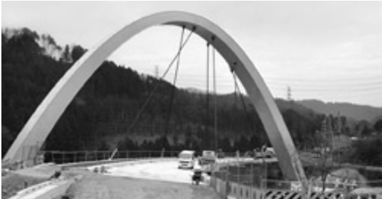
工事が進む矢柄橋
