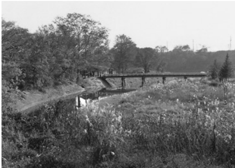
平井川新開橋付近
