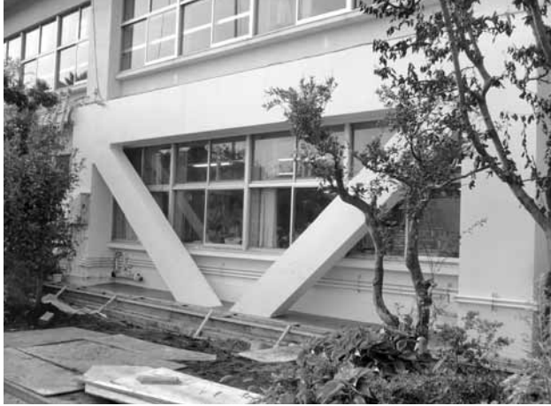
耐震化工事が進む秋多中学校の校舎
