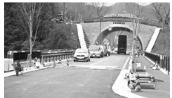
完成した前山トンネル
