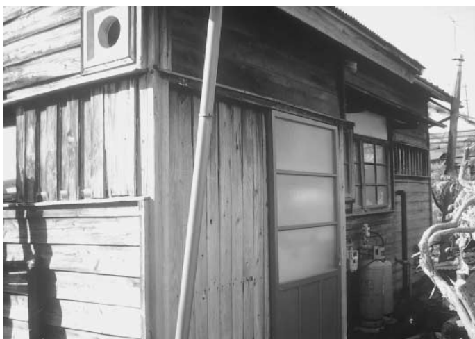
耐震化が求められる古い市営住宅
