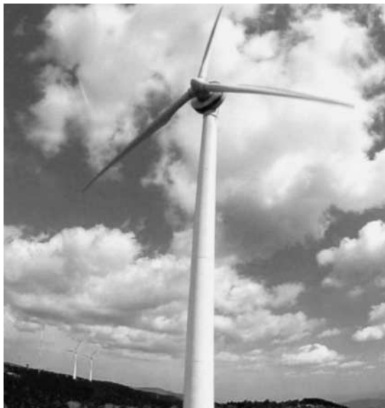
自然の力を利用した風力発電設備
