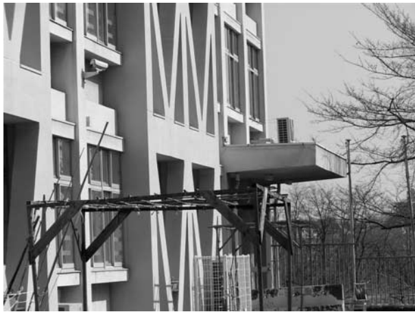
耐震化工事が完了した屋城小校舎
