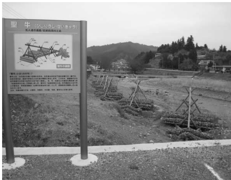
小和田グラウンド付近の聖牛 *聖牛…川の流れの勢いをとめるための木組み
